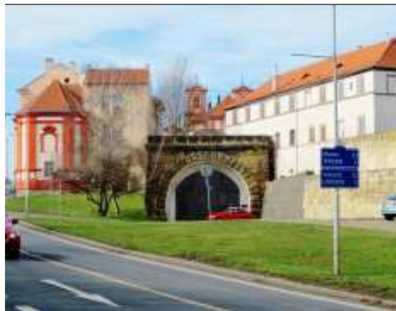
Pohled na východní portál někdejšího železničního tunelu, opuštěného v roce 1958.
