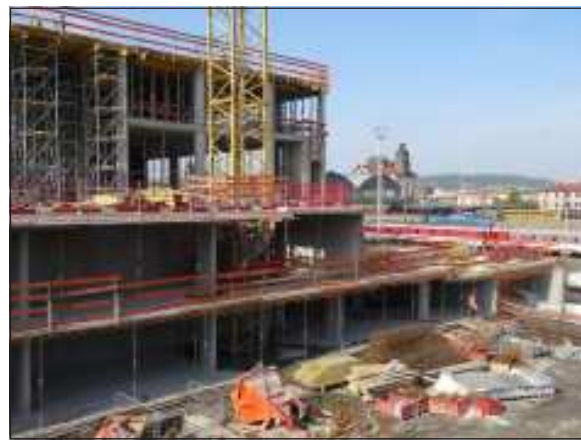
Snímek ze staveniště na pražském hlavním nádraží, 24. 4. 2018.
