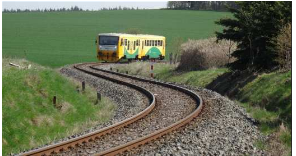
Výkopovými pracemi v letních měsících roku 1908 začaly stavební práce na trati Planá u Mariánských Lázní – Tachov, v čase žní ale záhy téměř ustaly. Námezdní dělníci z řad venkovského obyvatelstva si totiž chtěli prací na stavbě železnice pouze přilepšit. Dráhu se přesto podařilo 1. srpna 1910 uvést do provozu. Na snímku osobní vlak 7205 z Plané u M. Lázní do Domažlic v km 5,8 poblíž zastávky Tachov-Biletin. Snímek Michael Mareš
