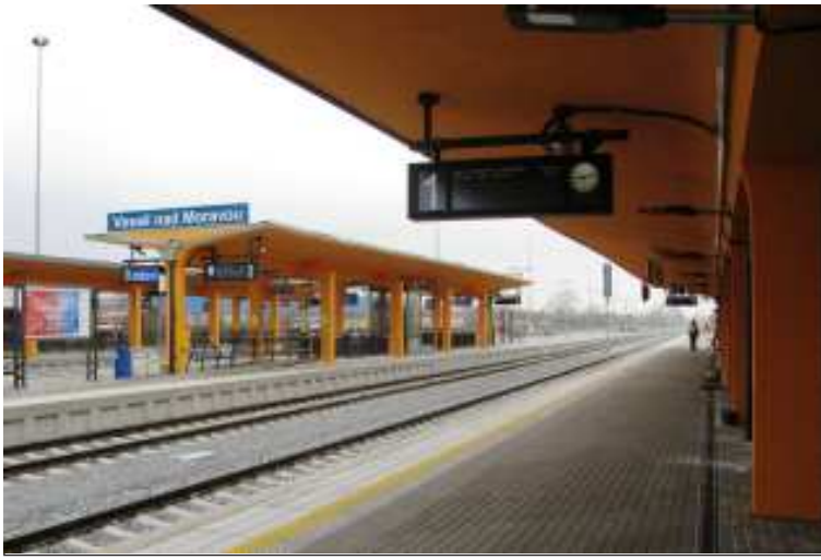
Vstupní poradou to v květnu roku 2015 začalo a v listopadu 2018 je rekonstrukce kolejíště a zabezpečovacího zařízení hotová.
