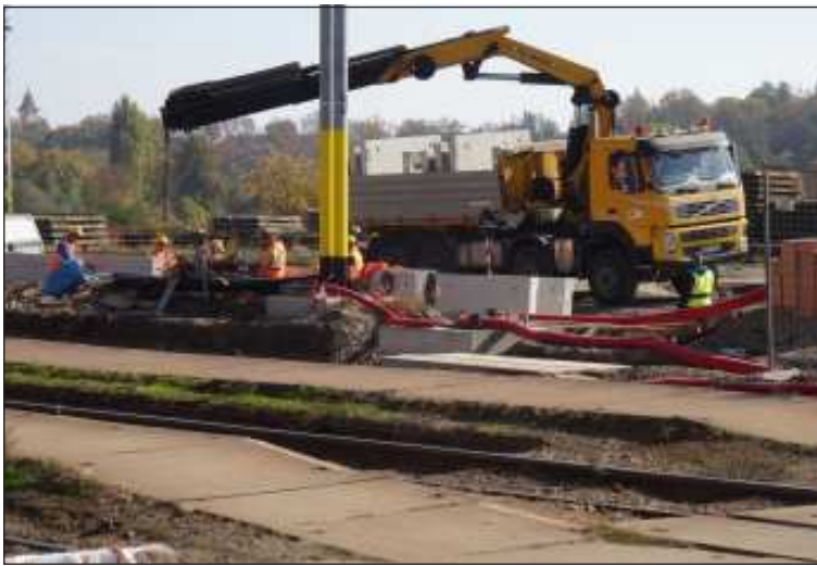
V rámci stavby dojde i na rekonstrukci celého kolejíště, novou podobu dostanou také perony. Počítá se s vybudováním nového ostrovního nástupiště s bezbariérovým přístupem a výtáhem na nástupiště.
