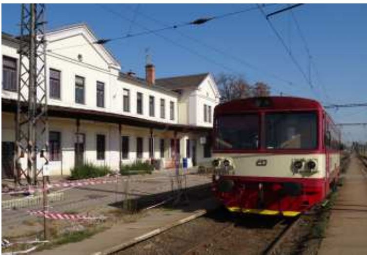
Na začátku letošního roku vydal Drážní úřad stavební povolení na modernizaci železniční stanice Jaroměř, rekonstrukce se však netýká budovy samotné.
