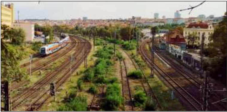
Pohled na bývalou zastávku Praha–Královské Vinohrady z nadhledu z portálu vlnohradských tunelů, právě kvůli stavbě dalšího tunelu byla zastávka v roce 1944 dočasně postavena mimo činnost. Ta dočasnost trvá 74 let.
