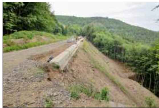
Pohled na opravovaný úsek, kde došlo v březnu loňského roku k sesuvu svahu. Opravné práce zde již směřují do finíse.
