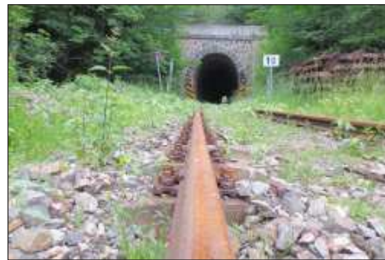
Koleje před Novoměstským tunelem (dlouhým 211 metrů) již více než rok bezdáně rezaví.
