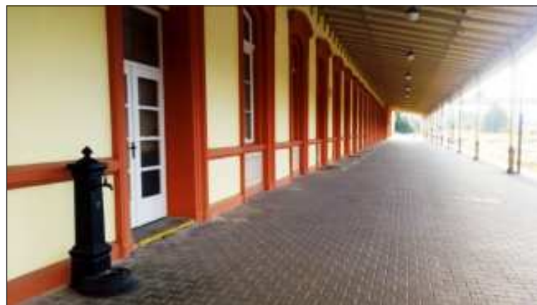
Výpravní budova žst Meziměstí se skví novotou, vadou na kráse je pouze nefungující nová (!) historická kašna na pitnou vodu, proč tam tedy byla vůbec instalována? Nádražní restaurace byla v roce 2016 bohužel zrušena.
