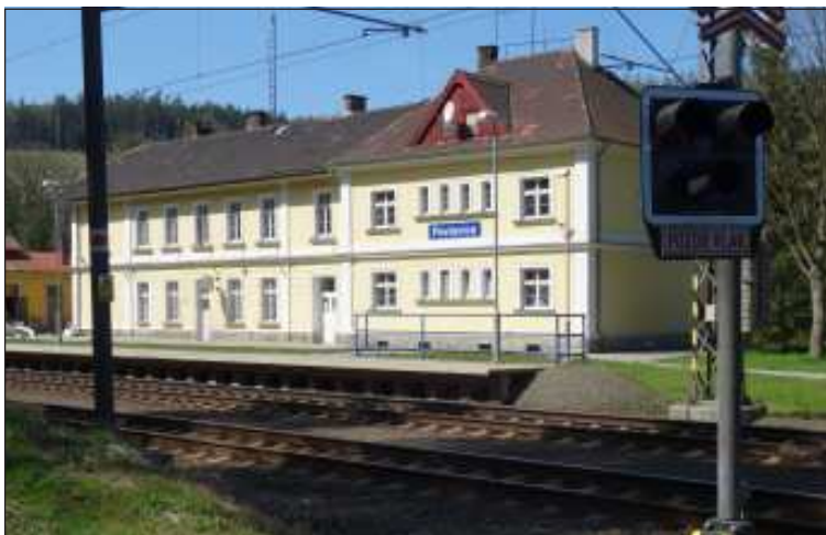
Dálkově řízená železniční stanice Pavlovice je nádherně opravená.
