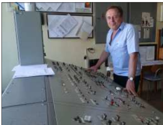
Dnes je vše řízeno přes elektronický dopravní deník. „Já to posílám odtud do Nýřan, ale vlaky nabízím z Chotěšova, a na druhou stranu do Holýšova. Skutečný odjezd dávám telefonem, i když bych nemusel,“ říká výpravčí Jaroslav Freisleben.
