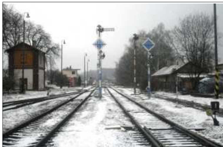
Železniční stanice Martinice v Krkonoších se pyšní tím, že je kompletně zachovalá v původní historické podobě, díky čemuž se stala národní kulturní památkou, což ovšem brání modernizaci zdejší železniční infrastruktury.
