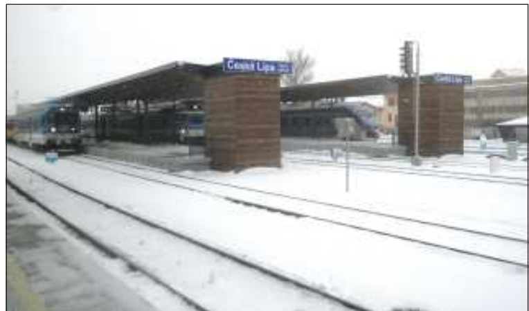
Dne 17. 12. 2016 byla v žst. Česká Lípa hlavní nádraží předána do užívání nová odbavovací hala a mimoúrovňová ostrovní nástupišťe s atypickým dřevěným zastrěšením. Vlaky jedoucí směrem na Lovosice však musí stále využívat původní nástupišťe v „lovosické kolejevé skupině“ (tzv. lovosické nástupišťe) u „staré výpravní budovy“ situované 250 m od nového nádraží. Tento nevyhovující stav by měl trvat do jara letošního roku, kdy bude dokončena přestavba kolejiště v této železniční stanici, v jejímž rámci bude lovosická trať napojena do nového nádraží.
