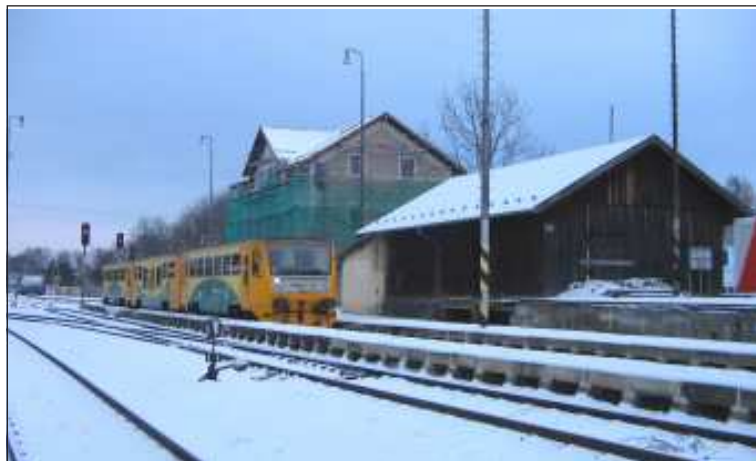
Vlak 2007 po dojezdu do koncové stanice Dobříš. 9. ledna v 9.25 h, v pozadí budova zahalená lešením.
