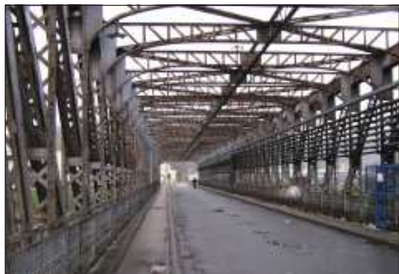
Jezový most Mířejovice u Nelahozevse, vlevo kolej jezové drážky, již bez troleje, 28. 12. 2016.
