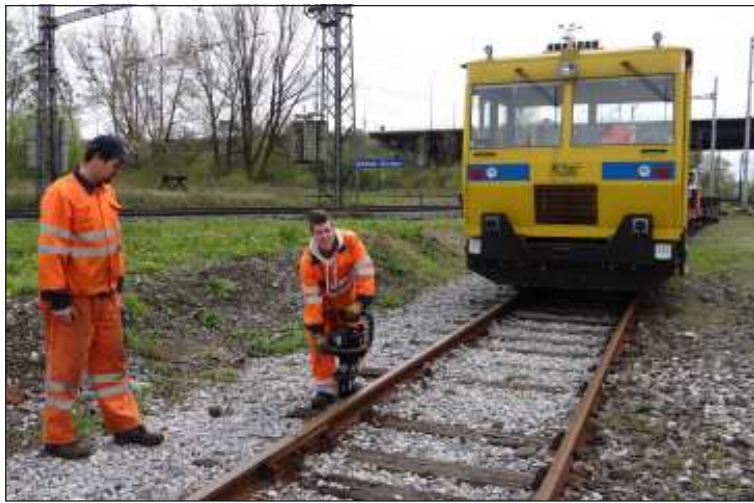
Při dotahování upevňovačů pomáhá udržujícím zaměstnancům jednomužný utahovací šroub.
