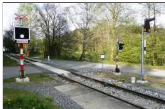
Modernizace vybraných železničních přejezdů na 90 km dlouhé regionální trati SŽDC č. 212 Čerčany – Světlá nad Sázavou zvýšila bezpečnost a plynulost silniční a železniční dopravy. Na snímku je jeden ze zrekonstruovaných železničních přejezdů P 5891 u vlakové zastávky Mrzkovice v km 43,8.
